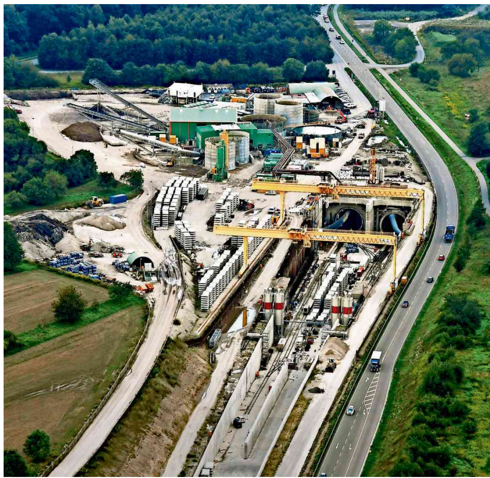
Blick von oben: das Nordportal des Rastatter Tunnels.
