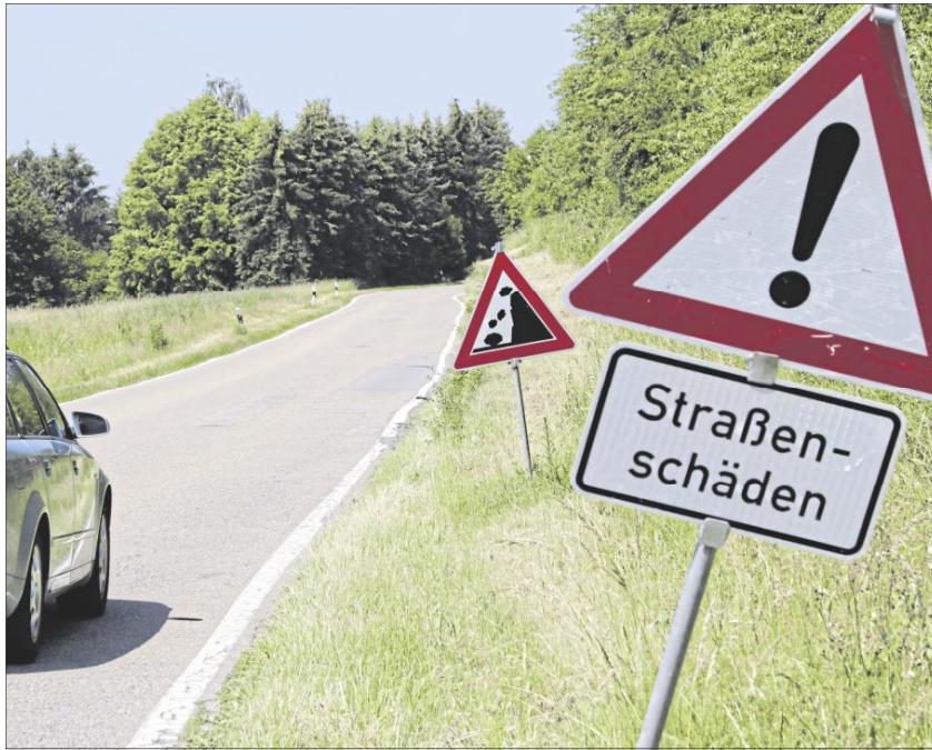
Die marode Holperpiste zwischen Gündelbach und Schützingen steht jetzt wieder auf der Sanierungsliste des Landes.
